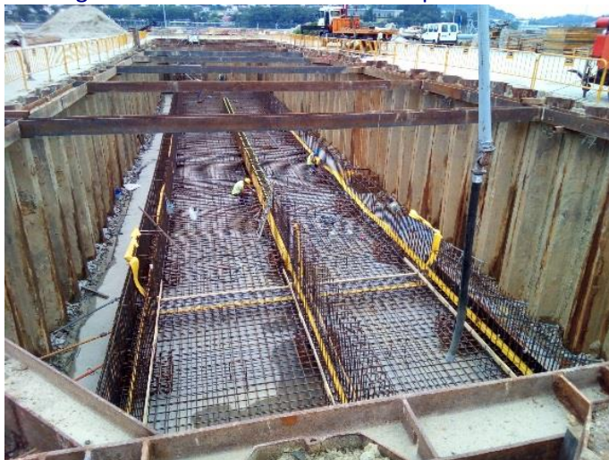
Obras del tanque de tormentas construido por la Autoridad Portuaria en el Puerto de Ferrol.
