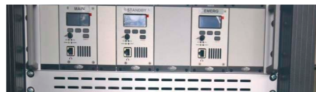
Transceptor de VHF marítimo en el Puerto de San Cibrao.
